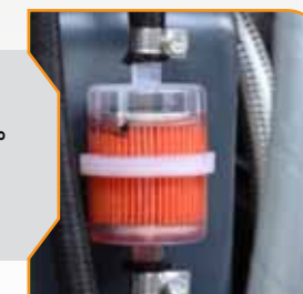
مجهز به فیلتر در قسمت ورودی آب به دستگاه
